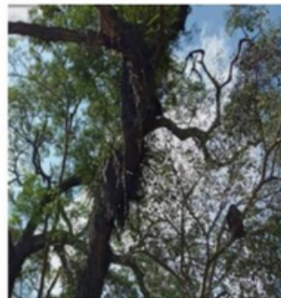
Estado de pudrición por nido de comején en Ramas y tallo en general.
